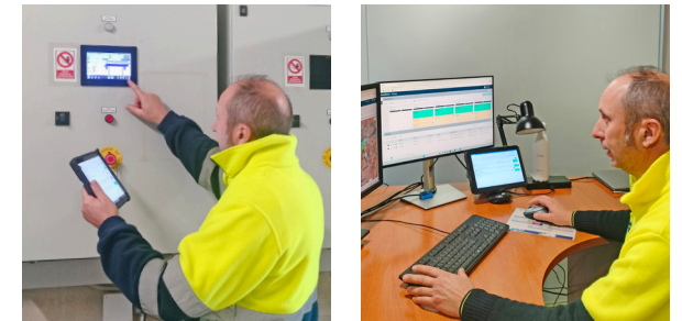
Las herramientas digitales y la IA permiten a los equipos supervisar las instalaciones en tiempo real, optimizar las operaciones y mejorar el rendimiento de los equipos.
