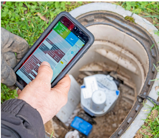
Sobre el terreno, nuestros técnicos utilizan a diario herramientas digitales para coordinar las intervenciones y optimizar el rendimiento de las redes de agua
