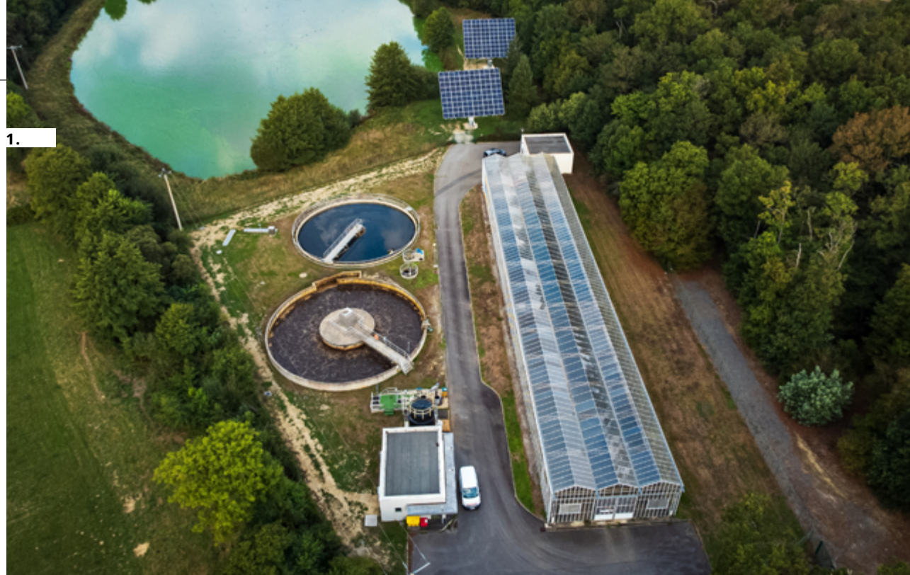
1. Para descarbonizar sus actividades, Saur multiplica las iniciativas que aprovechan las energías renovables (arriba, un seguidor solar). 2. Aqua-Chem diseña soluciones que minimizan el consumo de energía maximizando la recuperación de agua.
